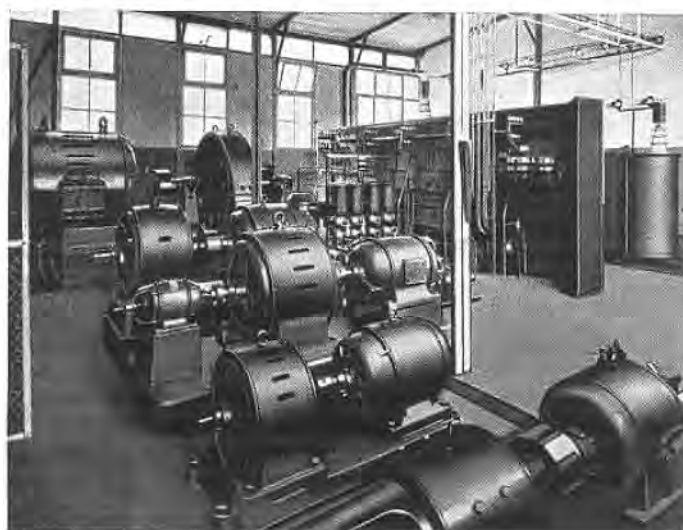
Bild 7. Versuchs- und Prüfanlage für Wasserkühl-Senderöhren im neuen Telefunken-Laboratorium, Wernerwerk, Siemensstadt: Die Umformeraggregate, Größe bis zu 250 Kilovoltampere, die über Transformatoren und Ventile bis zu 20 000 Volt Gleichspannung abgeben können.
