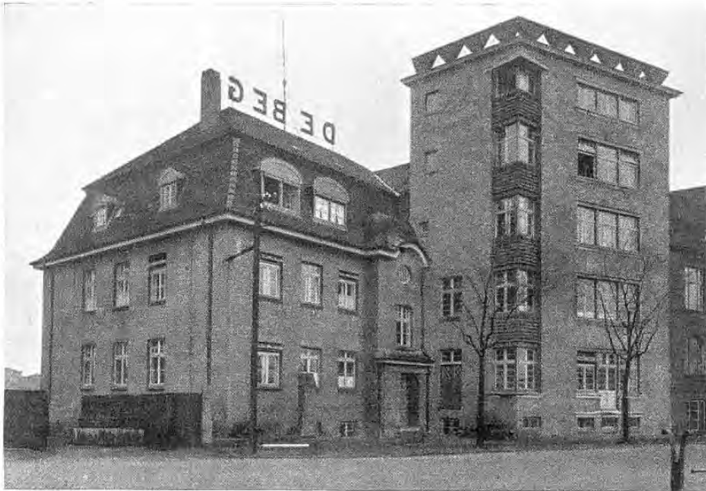
Bild 199. Betriebsgebäude der Debeg in Hamburg mit Hochhaus.
