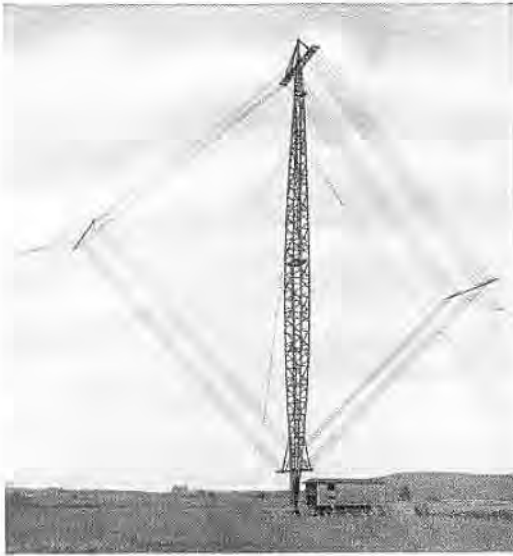
Bild 160. Aus der ersten Zeit des Gegenverkehrs mit Nordamerika: Behelfsmäßige Empfangsanlage Transradios in Geltow im Jahre 1919. 40 Meter-Holzast mit Rahmenantenne. Das zugehörige Empfangsgerät war im danebenstehenden Möbelwagen untergebracht.
