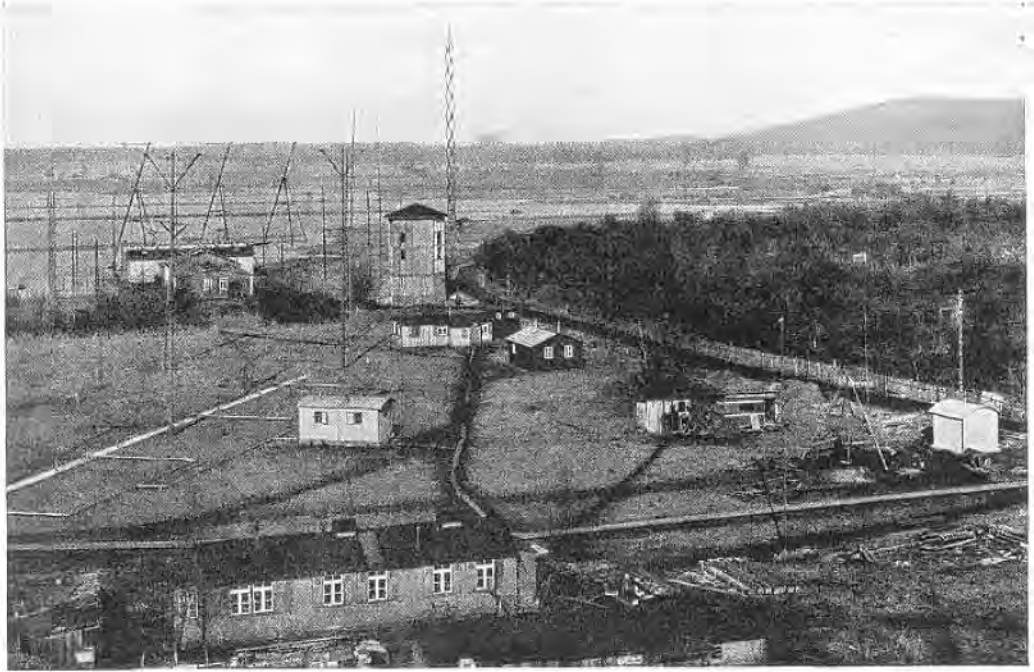
Bild 172. Das neue Gesicht Geltows: Weitgehende Einführung des Kurzwellenbetriebes. Zahlreiche Antennen verschiedener Form für gerichteten Kurzwellenempfang. Im Vordergrund Baracken und Antennenanlagen von Telefunken für Versuchszwecke.
