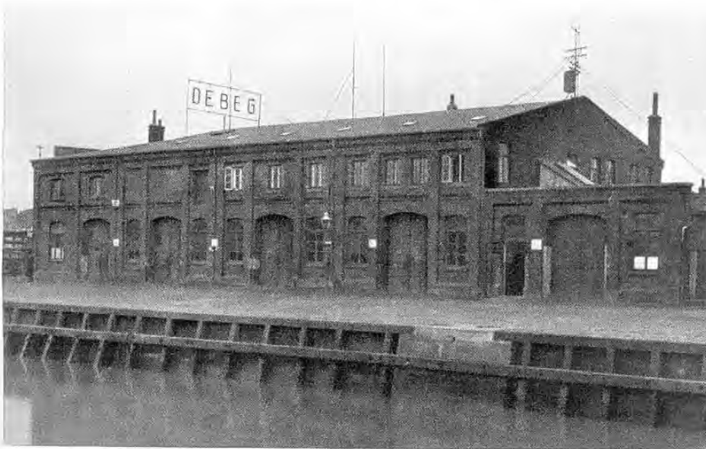
Bild 197. Betriebsgebäude der Debeg in Bremerhaven.
