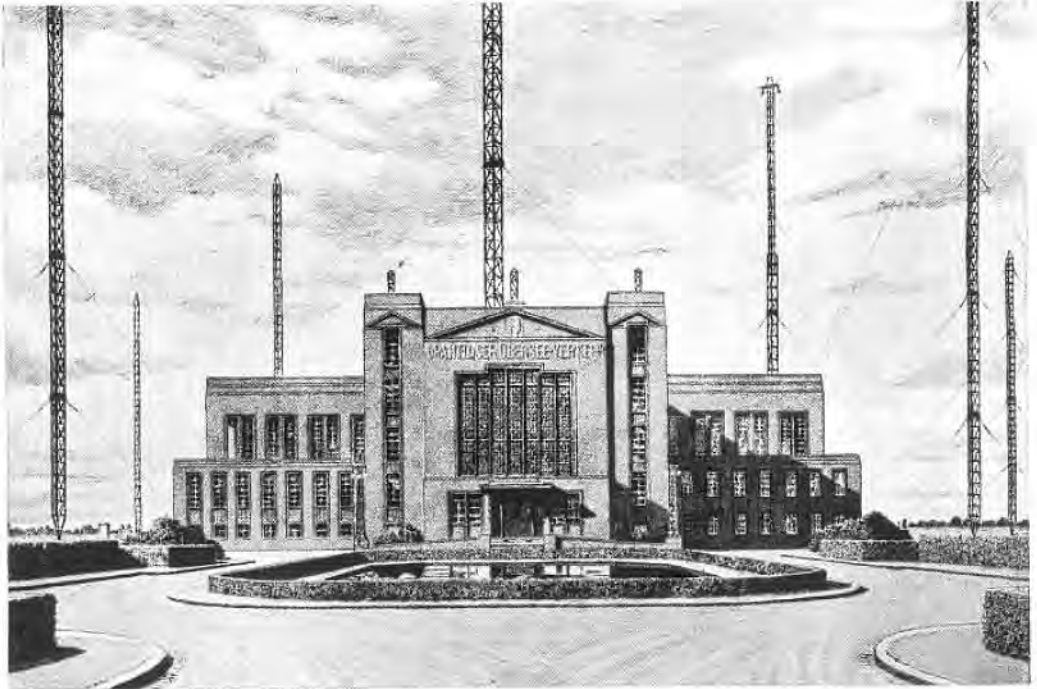
Bild 1. Vorderansicht des Großstations-Betriebsgebäudes Nauen, das nach dem Entwurf von Geheimrat Muthesius ausgeführt wurde. Wiedergabe einer Radierung von Heinrich Otto-Werniger. Die Großstation gehört der Transradio A. G. und wird von ihr betrieben.
