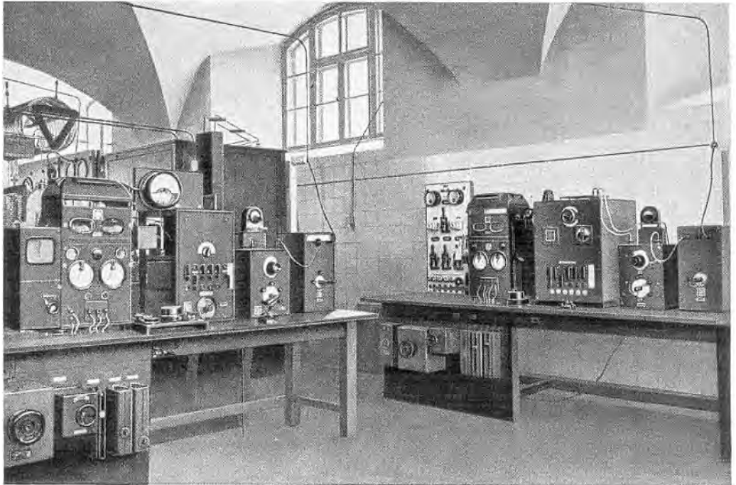
Bild 241. Teilansicht älterer, kleinerer Telefunken-Röhrensenderanlagen in der in Bild 240 gezeigten Hauptfunkstelle Königswusterhausen.
