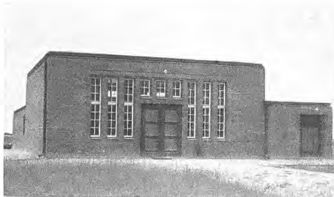
Bild 180. Neues Kurzwellen-Senderhaus I der Station Nauen, Bauentwurf von Geheimrat H. Muthesius. Enthält heute zwei Sender von je 20 Kilowatt für Obersee- und Weitverkehr.
