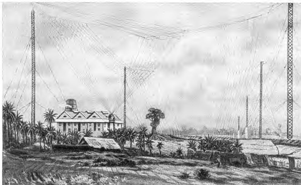
Bild 155. Großstation Kamina (Togo), eröffnet 1914. Arbeitete nach dem System der tönenden Löschfunken und diente dem Verkehr mit Nauen über 5200 Kilometer Entfernung. Zerstört im Weltkriege 1914. Nach einem Gemälde des Malers Ernst Vollbeh.
