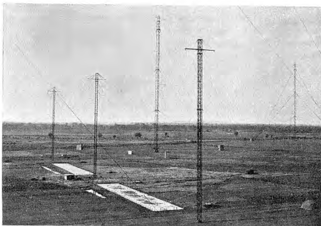
Bild 58. Das neue Gesicht Nauens; Strahlwerfer für Südamerikaverkehr, bestehend aus 2 mal 16 vertikalen Drähten und Reflektordrähten für Welle 25 Meter. Er wird durch 3 Masten von 60 Meter Höhe getragen.
