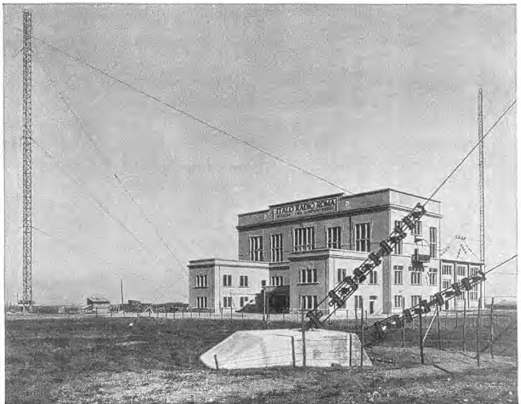
Bild 54. Gebäude der Großstation Rom, die Eigentum der Italo Radio, Società Italiana per i Servizi Radioelettrici ist. Eröffnet 1927. Maximale Antennenleistung 400 Kilowatt; 100 000 Meterampere.
