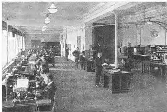
Bild 175. Ansicht der Berliner Transradio-Betriebszentrale 1925. Moderne Sende- und Empfangstische im großen Betriebsraum. Einzelheiten siehe Bild 177 und Bild 178. In der Mitte des Raumes der Funkleiter, ganz hinten der Zentralschaltplatz, einschließlich Klinkenschrank, Verstärker- und Gleichrichteranlagen.
